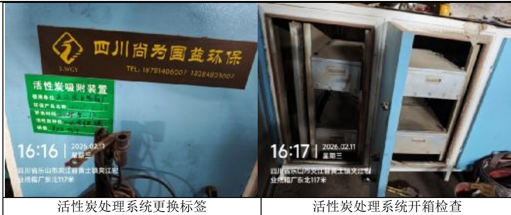
图 3.6-3 技改前印刷车间 VOCs 废气收集和处置措施照片
