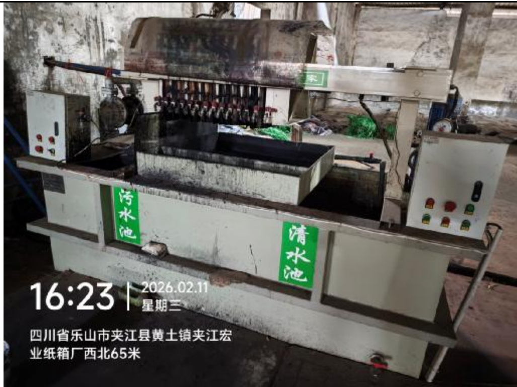
图 3.6-5 印刷机清洗废水一体化循环处理设备照片
